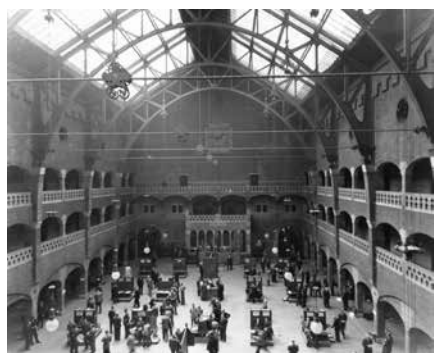
De Amsterdamse beurs 1950 Interieur van de Beurs van Berlage omstreeks 1950. Te zien zijn de karakteristieke banken waar de assuradeuren gebruik van maakten. Stadsarchief Amsterdam.
